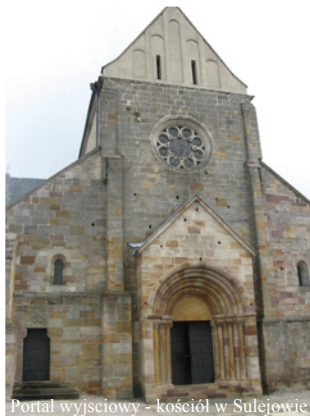
Portal wyjściowy - kościół w Sulejowie
