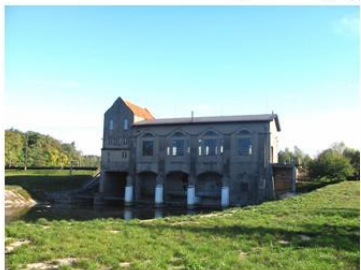
Elektrownia wodna z 1911
